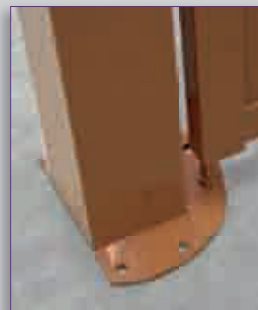
Poteau de section 150 x 150 mm
