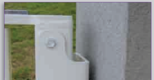
Poteau de section 80 x 40 mm
